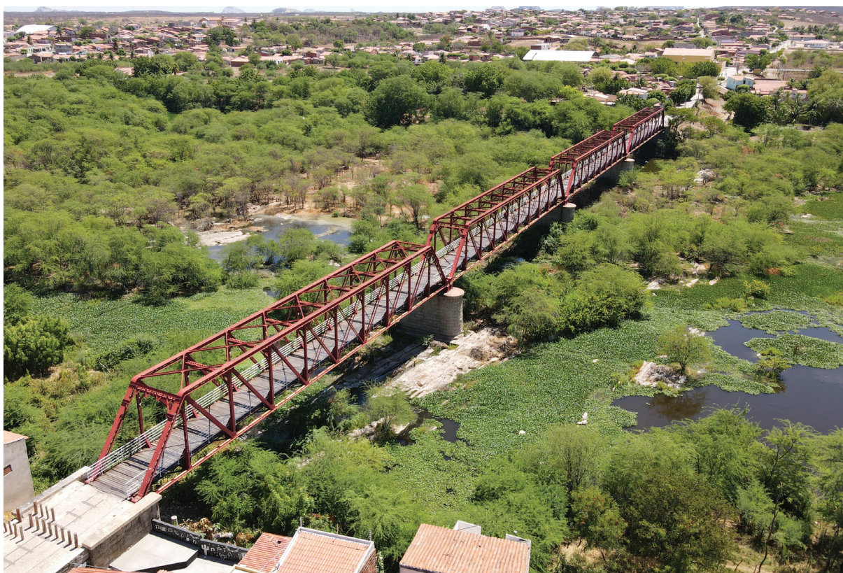
Ponte metálica - Quixeramobim
